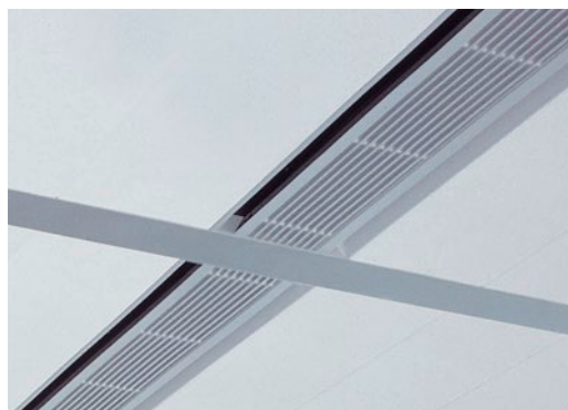
Klimatizační element integrovaný v podhledu OWA se systémem Bandraster
