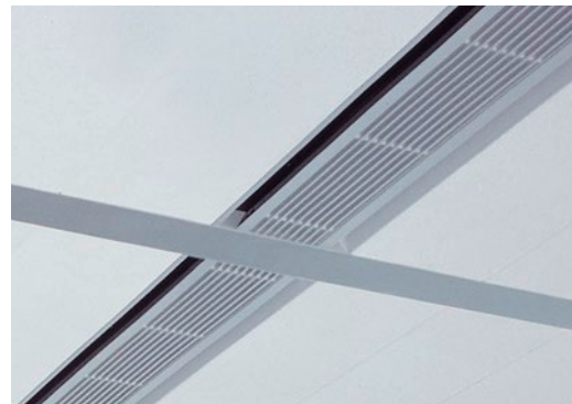
Klimatelement in OWA-Bandrasterdecke integriert
